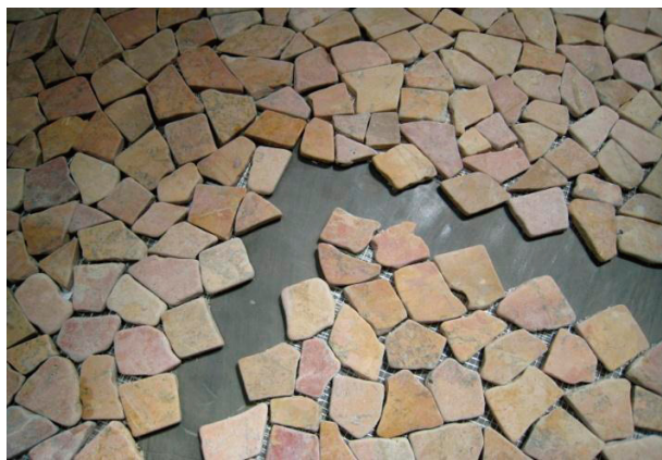
シート接合部分
