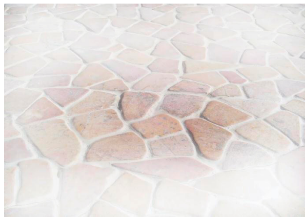
目地材は必ず充填してください
